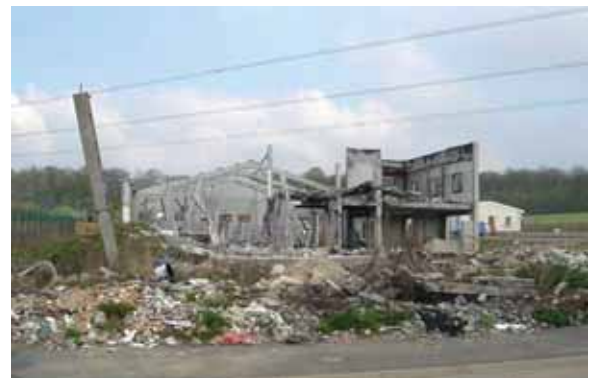
Entreprise ayant subi une explosion
