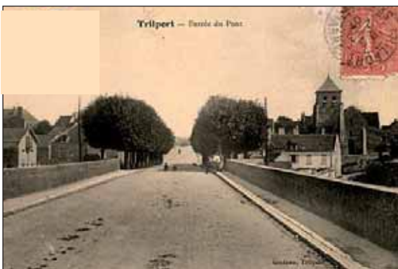
Entrée de ville Ouest
