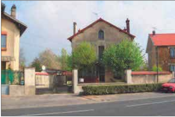
Bâti donnant sur la RD603
