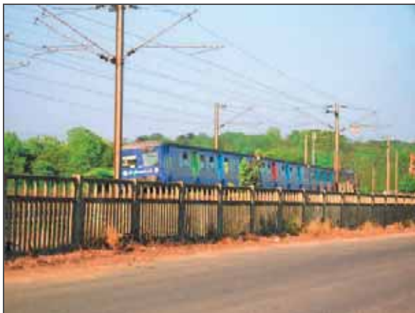
La voie ferrée
